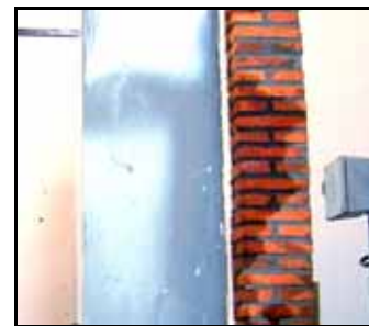
Vista lateral de la muestra tras el ensayo, donde se aprecia cómo el poliuretano se comportó como una barrera contra el agua, aún cuando esta llegó a saturar el ladrillo y el mortero.
