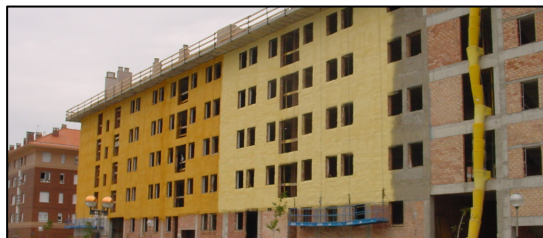
Proyección de poliuretano en fachada ventilada, antes de colocar el aplacado exterior.
