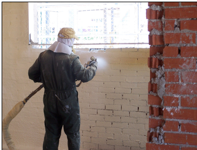
Una proyección de poliuretano sin enfoscado previo garantiza el máximo grado de impermeabilidad de la fachada.
